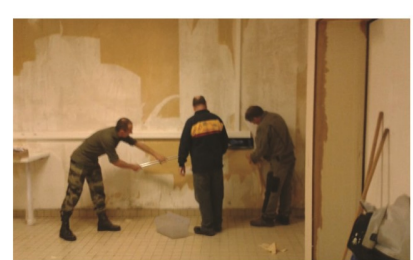
Travaux dans le bâtiment 023
