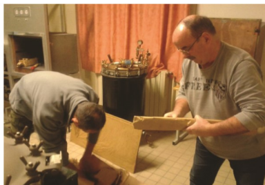
Amélioration de la salle de stérilisation
